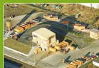
Estação de transferência de resíduos Güstrow
