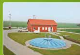
Unidade de tratamento de água Breege
