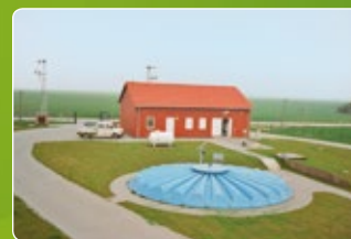
Oczyszczalnia cieków w Breege
