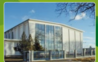
Budowla wodna w Wismar
